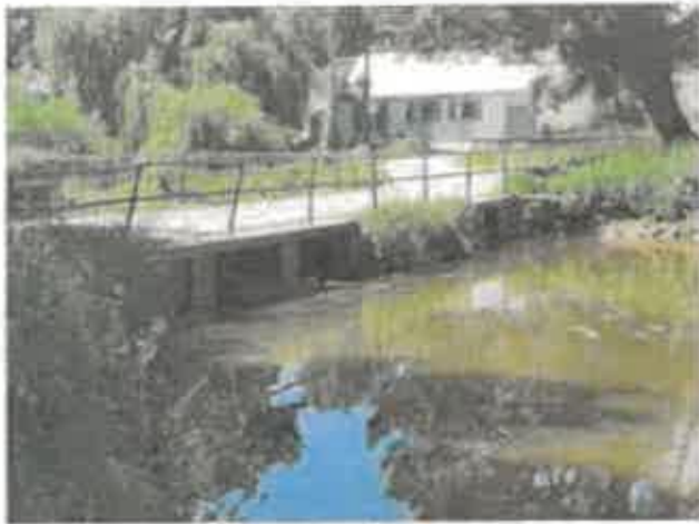
Photo 5 : Vue du pont de Vault depuis l'amont (Source : SCE)
