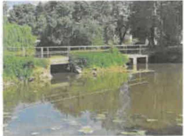
Photo 6 : Vue du pont de Vault depuis l'aval (Source : SCE)
